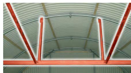
Structure amovible permettant le déplacement du tunnel.
