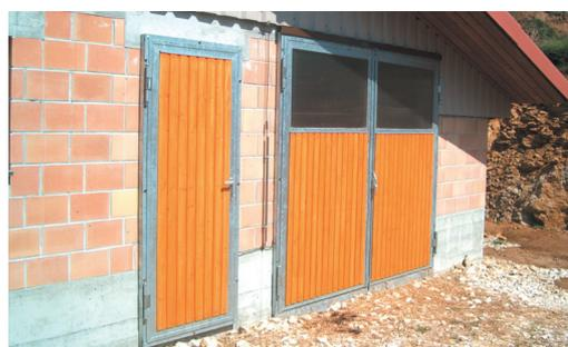
Portes sur mesure, super économiques : châssis galvanisé à chaud après fabrication.
