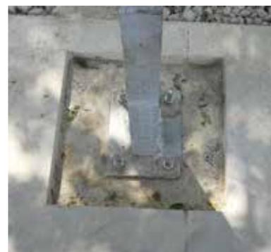
**Système d'ancrage au sol (galvanisé à froid Sendzimir):**
