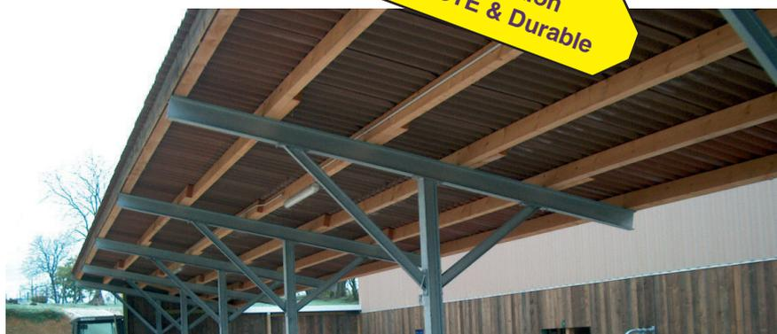
Supports de charpente à sceller, en poutrelles IPE & HEB, galvanisées à chaud après fabrication, selon dimensions ci-dessus (sans bois & sans toit).
