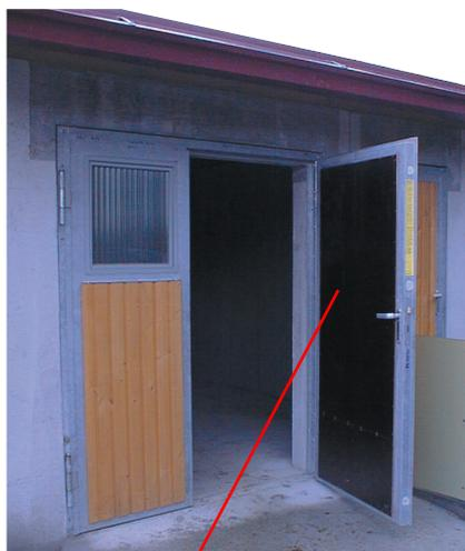
Porte isolée ESID501, en deux parties avec fenêtre fixe et habillage bois à l'extérieur & panneau marin à l'intérieur. Ouverture extérieure droite.
