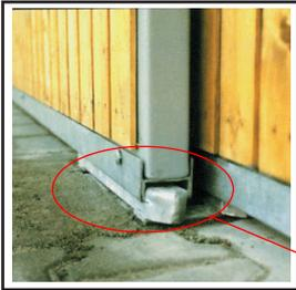
guide inférieur permettant un dégagement total du passage
