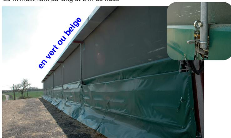
Des sangles fixées sur la sablière du bâtiment et reliées au sol, permettent d'assurer au rideau un guidage et une meilleure résistance au vent.
