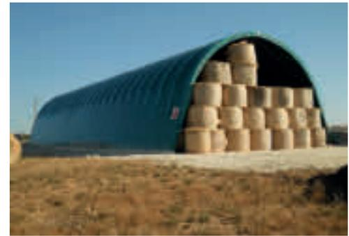
Standard Modell, gerüst aus Rundrohren. Abmessungen: Breite von 9,3 m, Höhe von 2,70 bis 4,50 m
