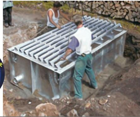
Ermöglicht allen Fahrzeugen freie Zufahrt bei gleichzeitigem zurückhalten der Tiere. Montagefertig für Grubenböden (Umrandung auffüllen), für alle Zuchttiere geeignet (Schafe, Rinder, ...) aber auch andere (Wildschweine, Rehe, ...) Als Option, seitliches Gatter, Gesamt-höhe 1,35 m / Höhe ab Boden 1.10 m.
