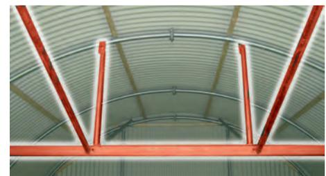
Structure amovible permettant le déplacement du tunnel.
