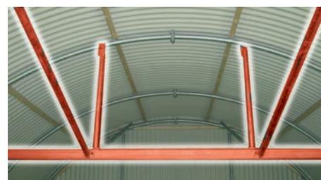
Structure amovible permettant le déplacement du tunnel.
