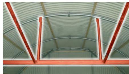
Structure amovible permettant le déplacement du tunnel.
