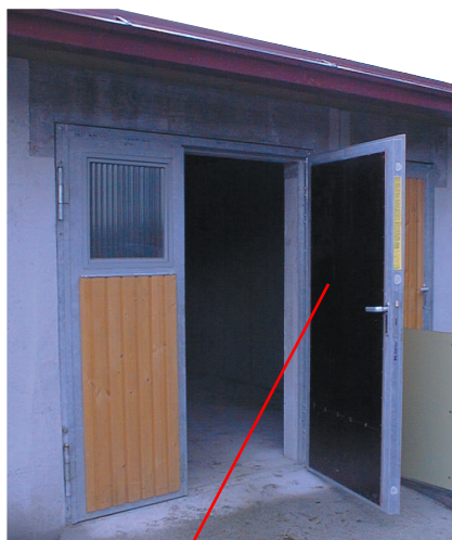
Porte isolée ESID501, en deux parties avec fenêtre fixe et habillage bois à extérieure & panneau marin à l'intérieur. Ouverture extérieure droite.
