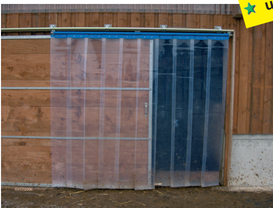
2 lanière souple, avec restriction de passage
