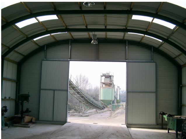
Châssis en poutrelles IPE
