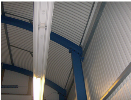
Châssis en poutrelles IPE
